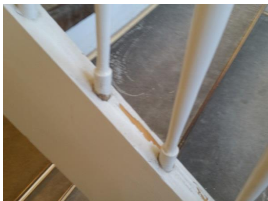
Afskallende maling på trappe
