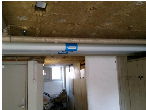
Kælder med isoleret loft
